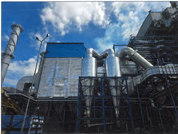
การติดตั้งระบบ Cyclone ของหม้อไอน้ำ ขนาด 170 ตันชั่วโมง (ชุดที่ 7)
